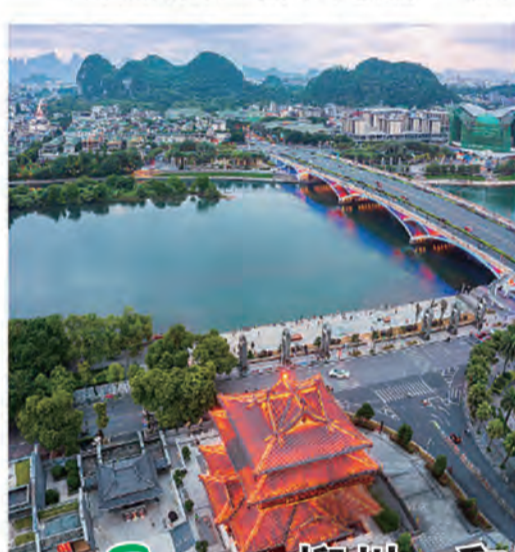
▼航拍解放橋以及橋畔的逍遙樓。
